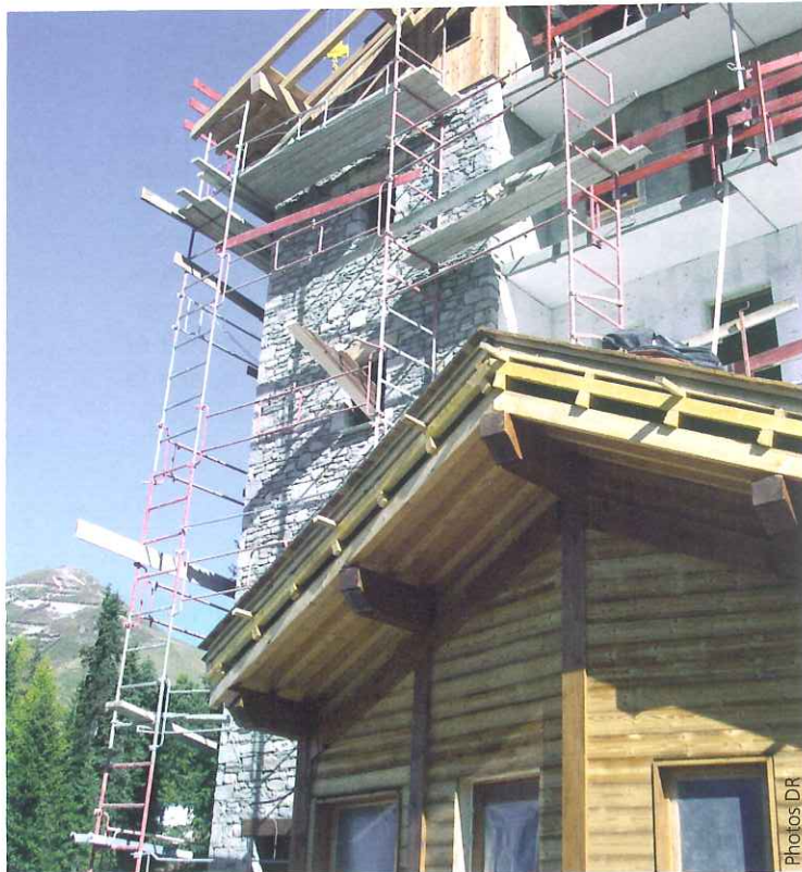
Façade en bois et pierre pour un hôtel 3 étoiles au pied des pistes.
