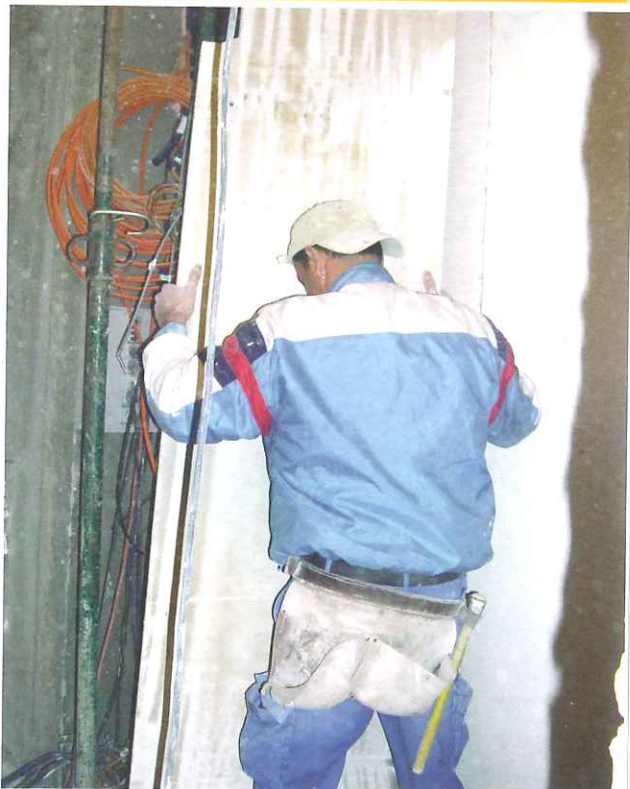
(à gauche) Les cloisons CHE sont posées debout et solidarisées entre elles par un joint de colle spéciale sur toute la hauteur.
